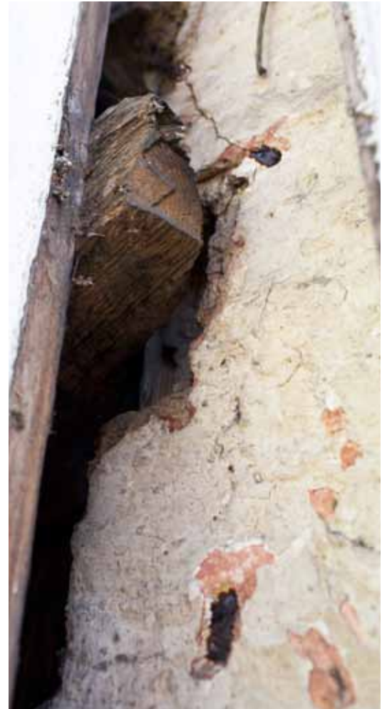
Nordveggen, østre hjørne: Bevart opprinnelig pussoverflate på teglforblending og utmurt bindingsverk
