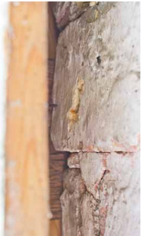
Annen etasje, nordvegg. Østre hjørne: Teglforbelding på utmurt bindingsverk
