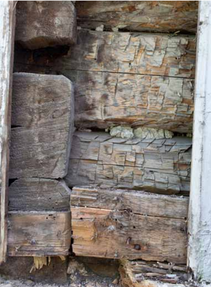
Første etasje, nordvegg. Østre hjørne: Enkelt utformet laft. Grovt tømmer med skavhugging for feste av rapp. Rester av kalkholdig mørtel i omfarene
