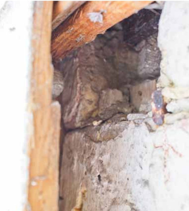
Annen etasje, nordvegg. Østre hjørne: Teglforblending på utmurt bindingsverk.
